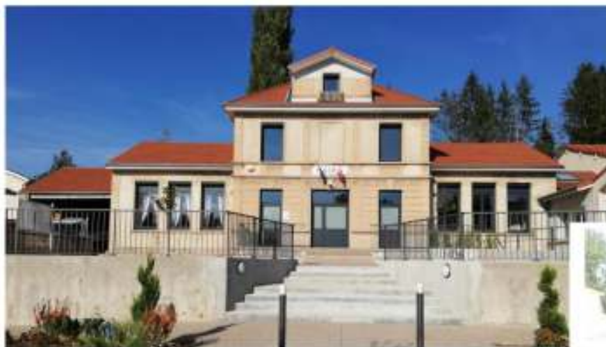
Travaux de réfections de la Mairie : Toiture et changement des fenêtres
